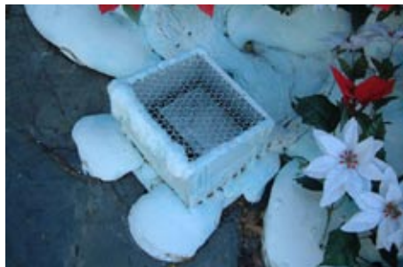
照明器具が剥き出しにならない配慮
