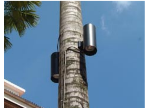
ヤシの木に取り付けられたアップパー&ダウンの照明器具
