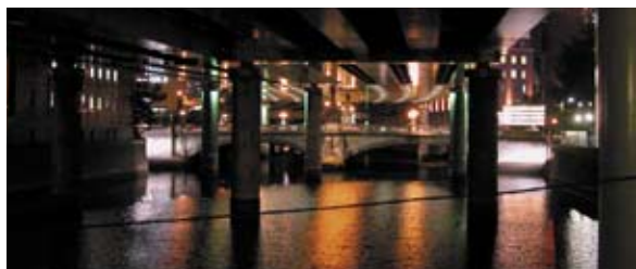
日本橋川に架かる他の橋より日本橋を望む
