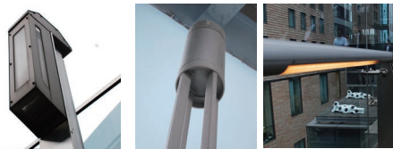
汐留の歩道照明、手すり部に組み込まれた照明も。
