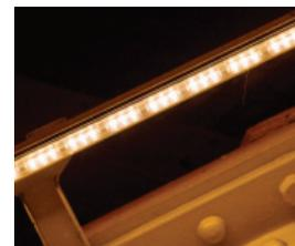
マルギット橋アーチ部分のLED器具。直接見えないように遮光もしている。
