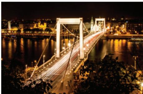
電球色(3000K)のランプが使用されたエルジェベート橋。周囲が高圧ナトリウムランプのオレンジ色であるため一際白く見える。
