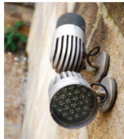
橋の外壁に設置されたLED投光器
