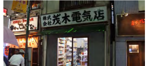
歌舞伎町の光を支えてきた電気店昔ながらのシンプルな看板照明が設置されている
