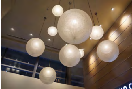
新宿東宝ビル内のオシャレな照明壁面は反射グレアが生じている
