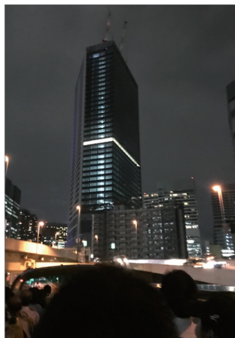
建設現場の光のライン
