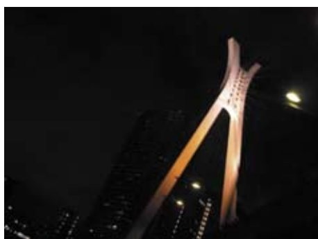
シンプルなグラデーションが綺麗な中央大橋
