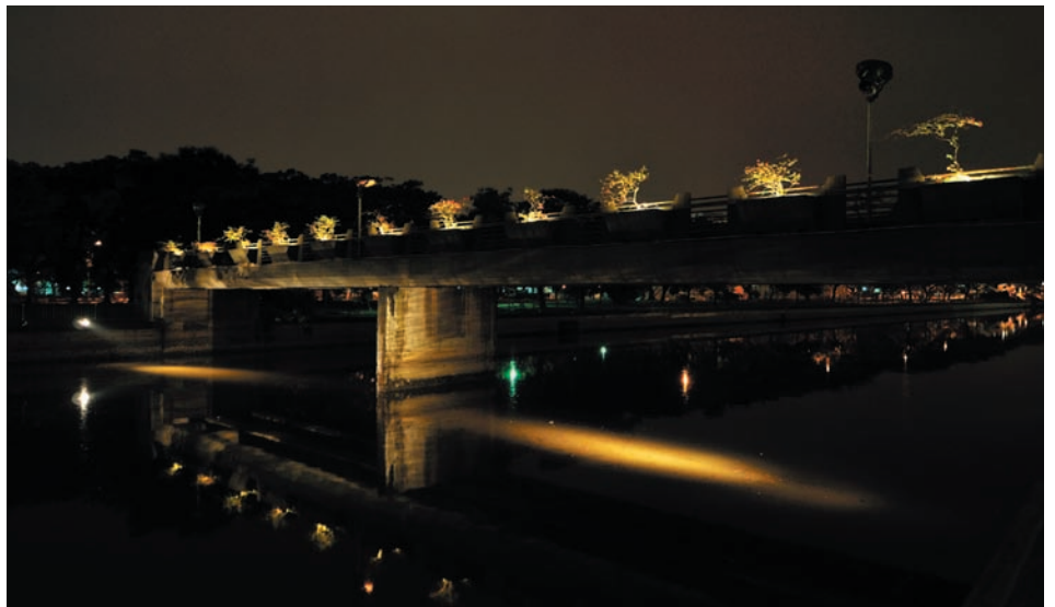
小さな橋では橋脚をスポットライトで浮かび上がらせ、欄干のプランターベットの蛍光灯を仕込んでアクセントをつけました。既存のポール灯の光は覆いをつけて隠しています。
