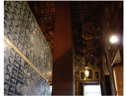
人の歩く空間は白色の蛍光灯、金色の大仏を照らすには色温度の低いメタルハイドランプ、真珠色の象嵌が施された大仏の足裏には色温度の高いメタルハイドランプ。器具の設置は無造作ながらも、光源の選定に明らかな配慮があり、大仏の存在感が演出されていた。
