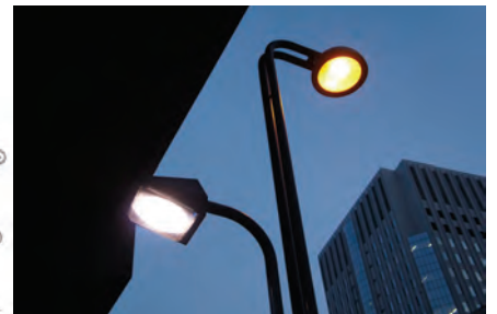
車道と歩道で色温度が違う街路灯
