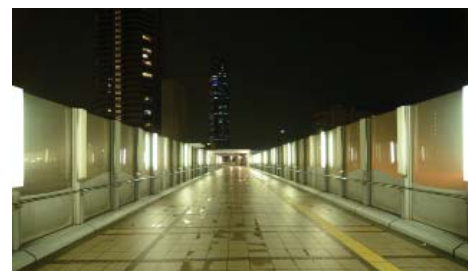
間引き点灯しても明るすぎる歩道橋
