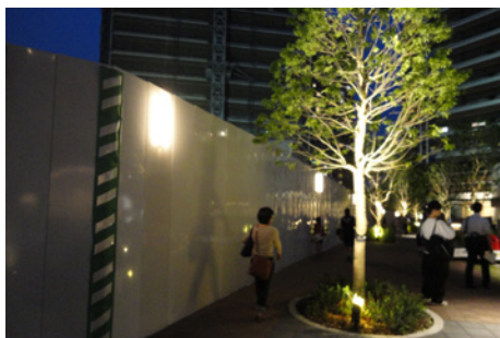
柏の葉 隠れ英雄、工事用仮囲いにあった3,000Kの仮設照明
