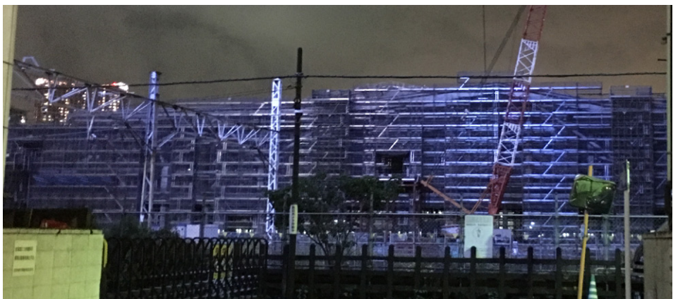
青い看板の光が反射している新駅工事現場
