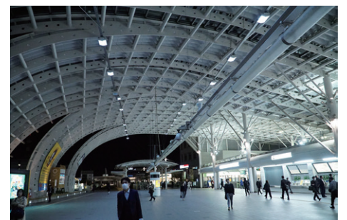
さいたま新都心駅コンコースはLED化されていた
