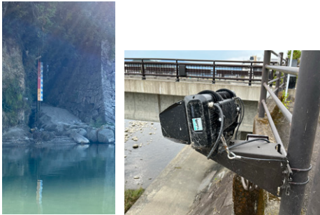
橋のライトアップのためのRGB投光器 城壁脇の水位計の水位と連動し、色でアラートを発する
