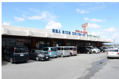
室内に届く強い日差しをカットするため、軒を長く設計した建物(シーサイドドライブイン)
