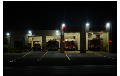
米軍の消防署は投光器が敷地を照らす、深くてかっこいい
