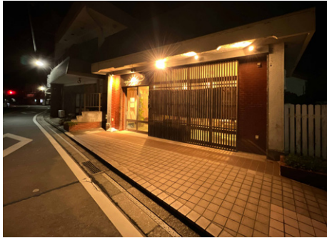
水平方向に向けられた店前照明。通り全体も明るくする
