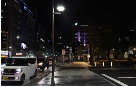
車道側と歩道側で、高さだけでなく灯具の配光も異なる。大通りの整然とした光に対し、公園から明かりが漏れる。
