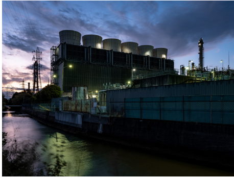
塩浜地区の工場夜景、6 つ並んだ冷却塔が特徴的
