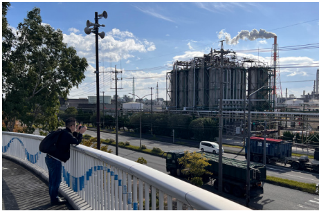
シドニー港通り前の歩道橋から眺める工場
