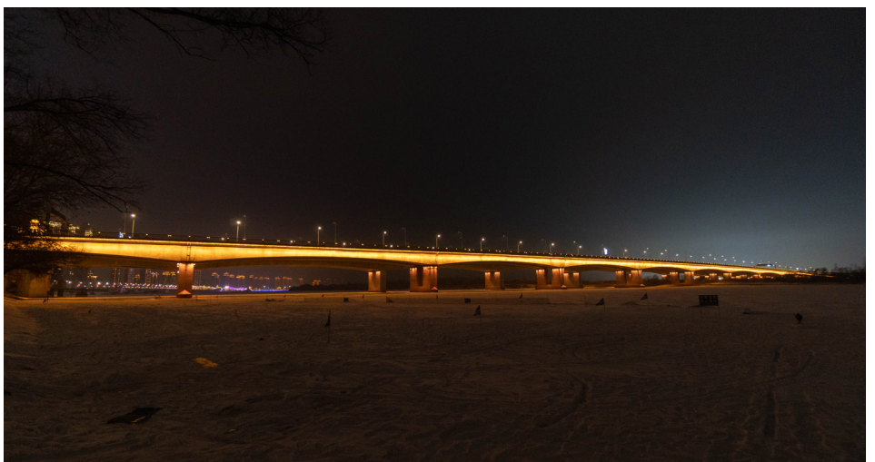
橋の側面が間接照明によって照らされ、光の帯がまっすぐ一直線に伸びる
