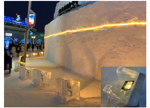
氷のガードに覆われた外照式フラッドライト
