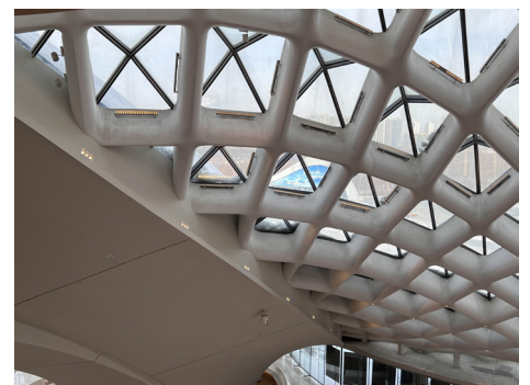
天井斜め格子構造を照らす照明器具
