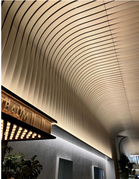
壁面上部の間接照明で間全体をやわらかく包み込む照明
